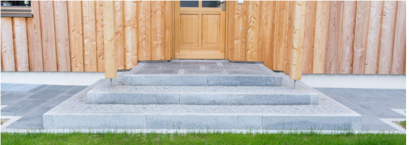
Granit Leistensteine gesägt und geflammt als Stellstufen
