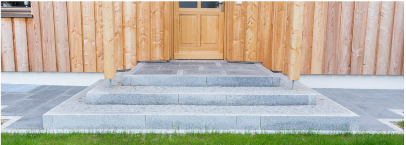
Granit Leistensteine gesägt und geflammt als Stellstufen
